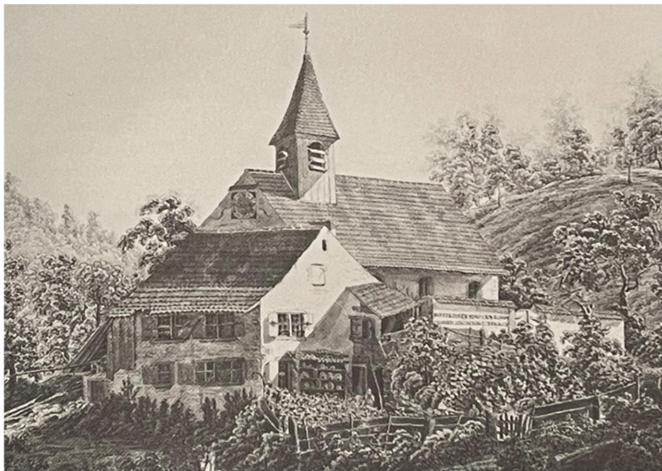
Kirche Reigoldswil und Schulhaus um 1810.
