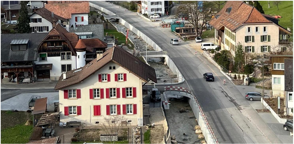
Abb. 7: Foto der Bauarbeiten auf der Kantonsstrasse (Quelle: bl.ch)
