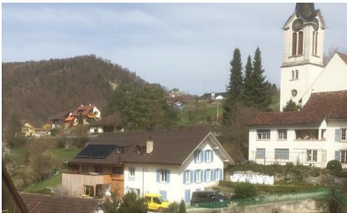
Die Solaranlage auf dem Dach der Chilchägerten 9
